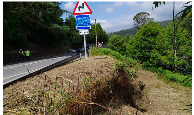
Acera de losas de piedra (p.k. 3+950) bajo la cual se deberá instalar el colector longitudinal. Se aprecia el replanteo de la línea de media tensión soterrada existente.
