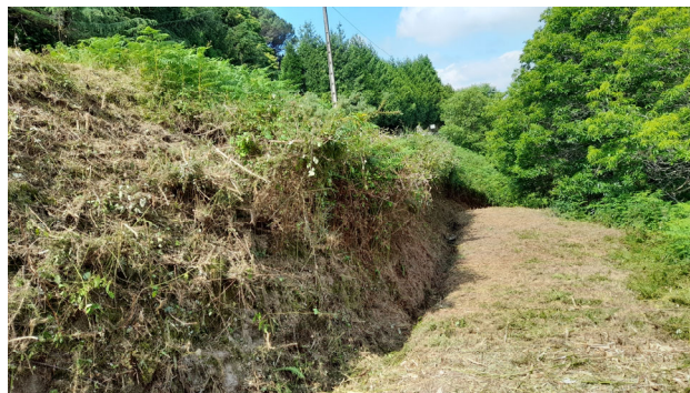
Cuneta de pie de terraplén en tierras existente en el entorno del p.k. 3+670 aproximadamente.
