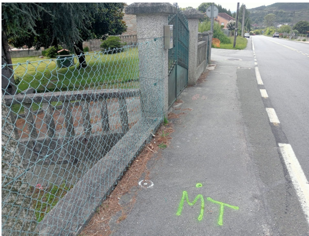
Vista de la zona donde el tramo de colector longitudinal recogido en el presente anteproyecto se conectará al previsto en el proyecto de mejora de la carretera PO-223 (p.k. 3+900)
