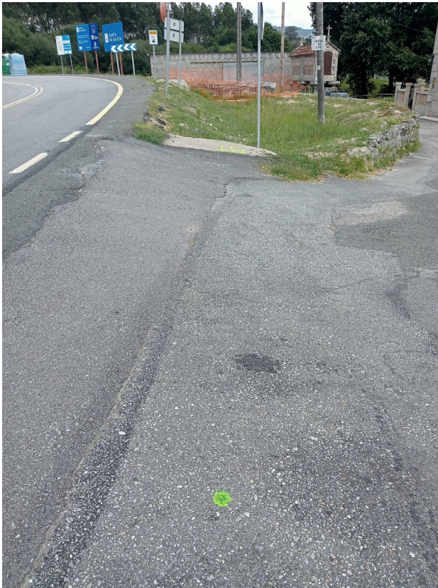
Vista del entorno del lavadero (p.k. 4+400) y el vial de acceso bajo el que se deberá ejecutar el cruce del colector longitudinal.
