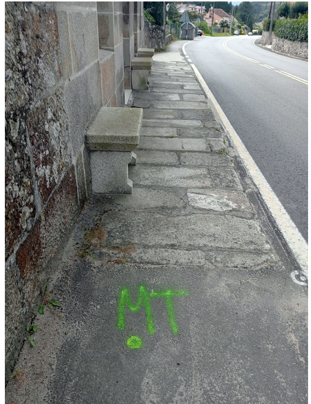
Acera de losas de piedra (p.k. 3+950) bajo la cual se deberá instalar el colector longitudinal. Se aprecia el replanteo de la línea de media tensión soterrada existente.
